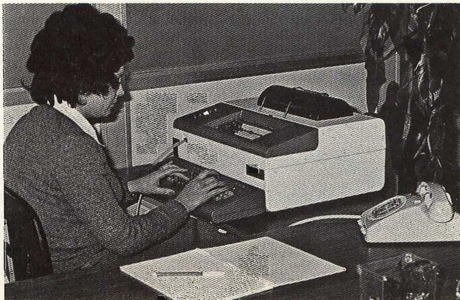
Fig. 1 - Una delle più moderne telescriventi elettroniche tipo start-stop, velocità 50 ÷ 100 baud: la CME 2000.
